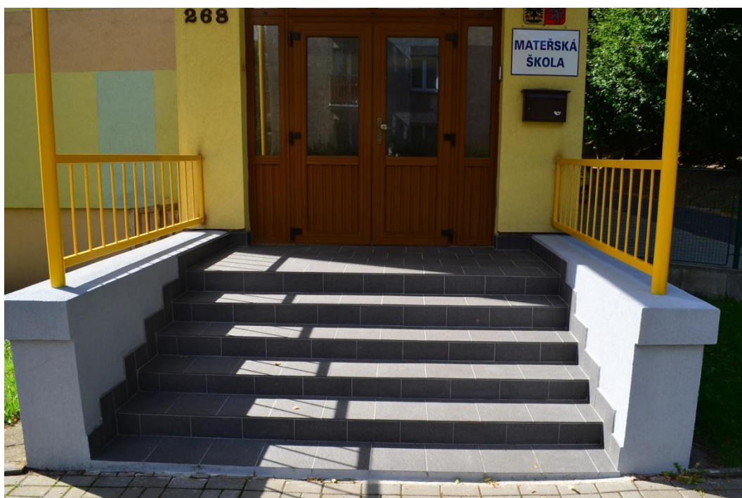
Nové vstupní schodiště v MŠ Žižkova
