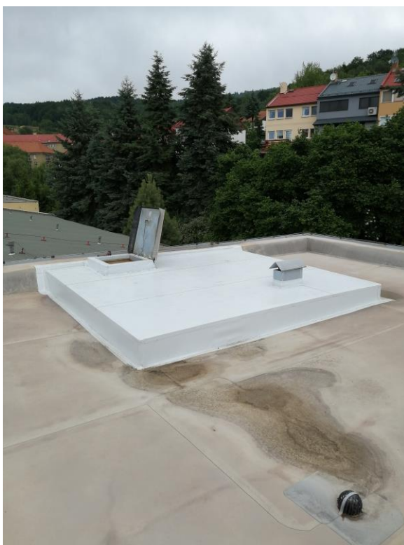
Oprava střešní výstupní šachty
