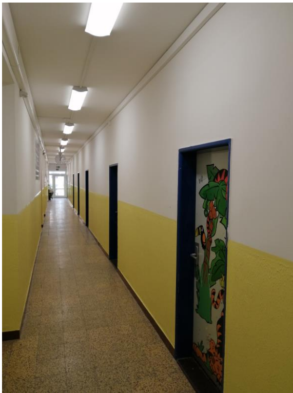
Malování objektu E
