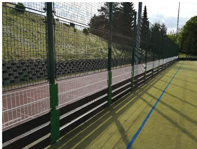
Oprava oplocení na školním hřišti
