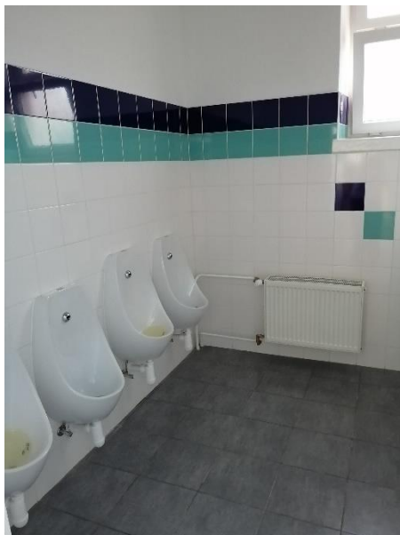
Rekonstrukce toalet v ZŠ – třetí etapa (dotace)
